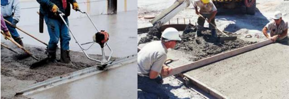
Resim 2.6: Betonun ilk düzeltme işlemi
