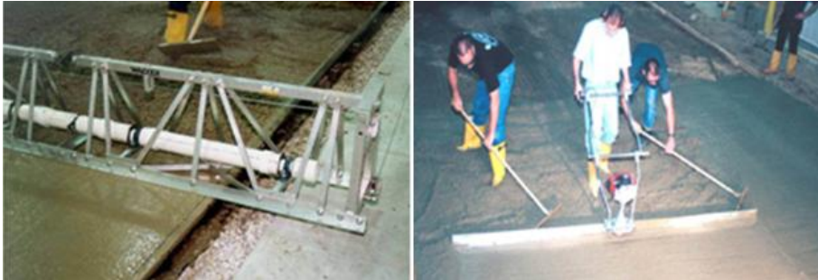
Resim 1.15: Yüzey vibratör kullanımı
