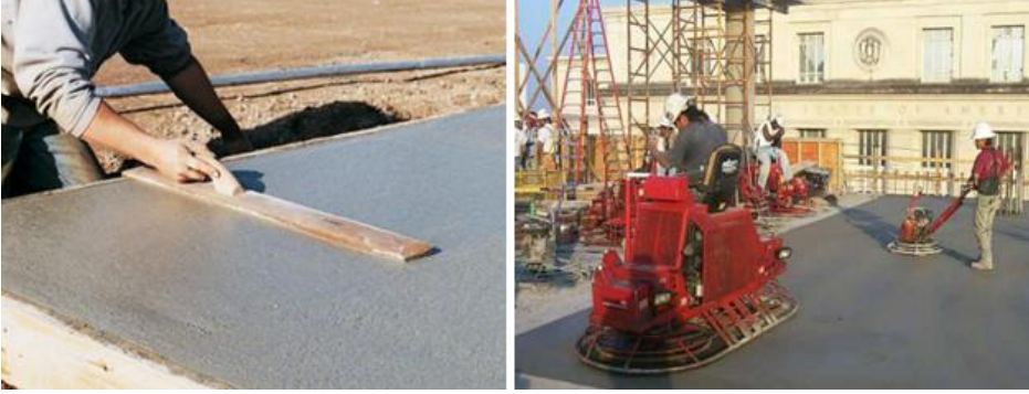
Resim 2.7. Betonun son dzeltme iřlemi
