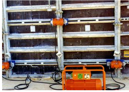
Resim 1.12: Elektrikli kalıp vibratörü
