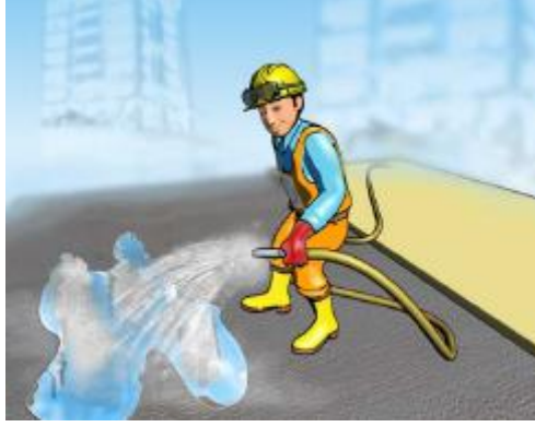
Resim 3.1. Betonun su ile korunması
