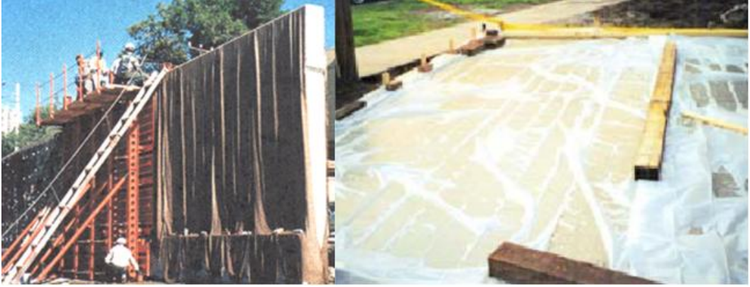
Resim 3.5. Branda ile perde duvarının korunması
