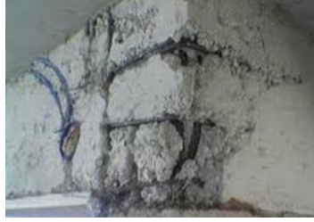
Resim 1.18: Betonda segregasyon
