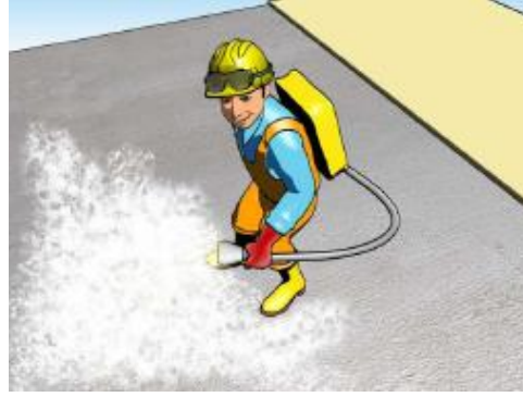
Resim 3.3. Betonun kimyasal maddelerle korunması
