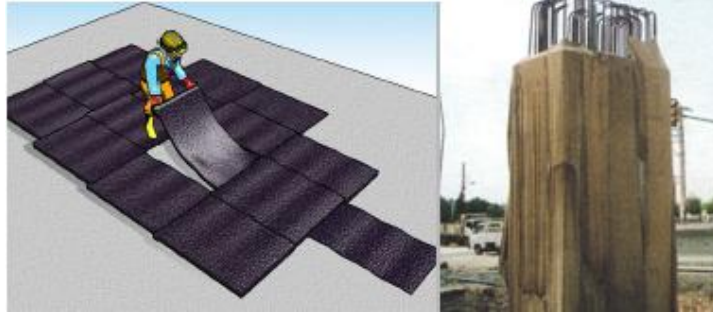
Resim 3.4. Betonun polietilen örtülerle korunması
