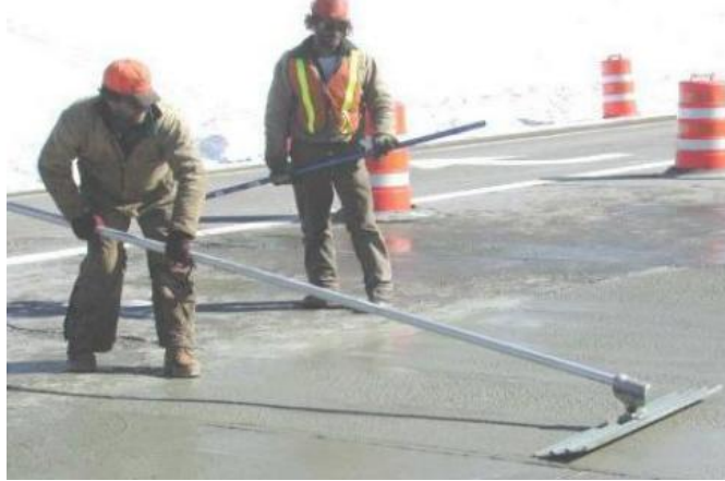
Resim 2.5: Betonun elle kalıba göre düzeltme
