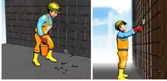
Resim 1.9: Kalıbın temizlenmesi ve yağlanması
