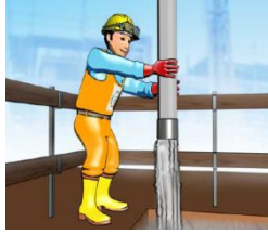
Resim 1.7: Betonun kalıba dökülmesi
